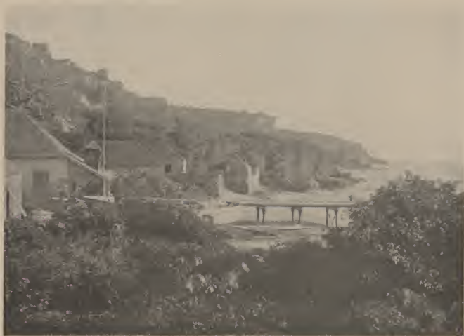
206. AANLEGSTEIGER IN DE ORANJEBAAI
